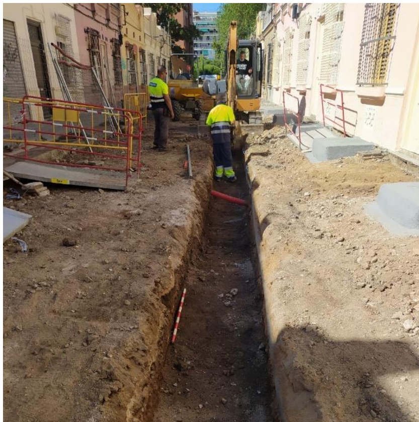
Figura 8. Fotografia de la rasa a l'acabar els treballs d'excavació.
