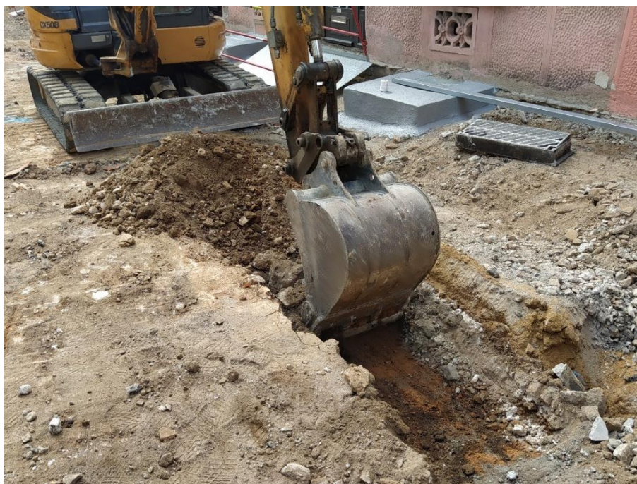
Figura 5. Fotografia en el moment de la realització de la rasa.
